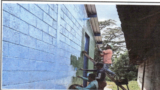
Foto 4: Aplicación de pintura en las paredes del Edificio Escolar
