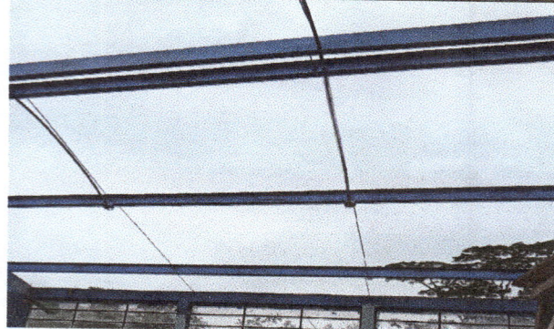
Foto 2: Aplicación de pintura Preventiva en la estructura metálica del Edificio Escolar
