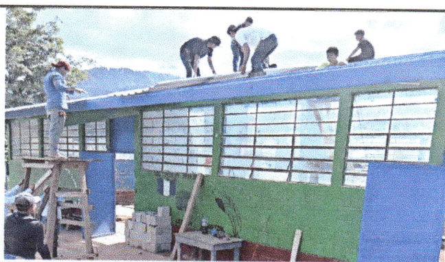
Foto 3: Colocación de techo del Edificio Escolar
