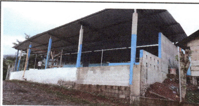
Foto 6: Ampliación y mejoramiento de muro de contención Frontal del Edificio
